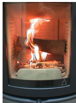
III. 3 : Chiusura presa dell'aria primaria
